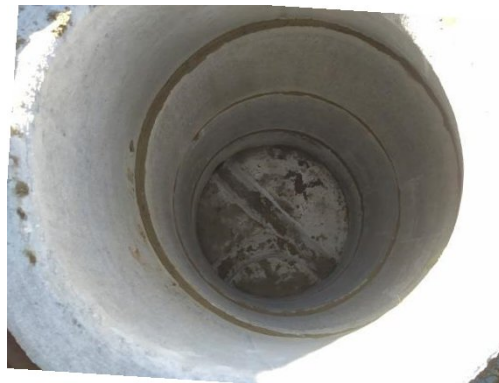
Bild 2: offene Rohrdurchführung
