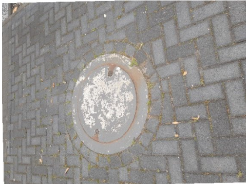
Bild 1: sichtbarer und zugänglicher Kontrollschacht
