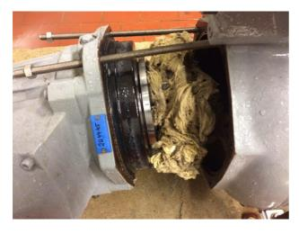
Immer häufiger verstopfen die Pumpen in der SWPA Wiesenstraße aufgrund von Verzopfungen. Die dicken "Zöpfe" entstehen durch Feuchttücher, Hygieneartikel, Unterwäsche, Putzlappen und Wischer, die sich in der Kanalisation fest miteinander verbinden und verflechten. Sie fließen über das Kanalsystem der Pumpstation Wiesenstraße zu und wickeln sich um die Laufräder, wie dieses Foto zeigt, bis die Pumpe nicht mehr fördert.
