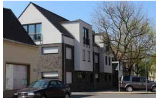
ABB 032 Wohnungsneubau im historischen Ortskern Quelle: SSR
