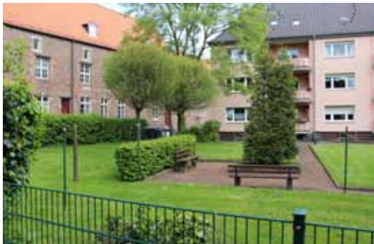
ABB 030 Wohngebäude mit gemeinschaftlichem Hof Quelle: SSR
