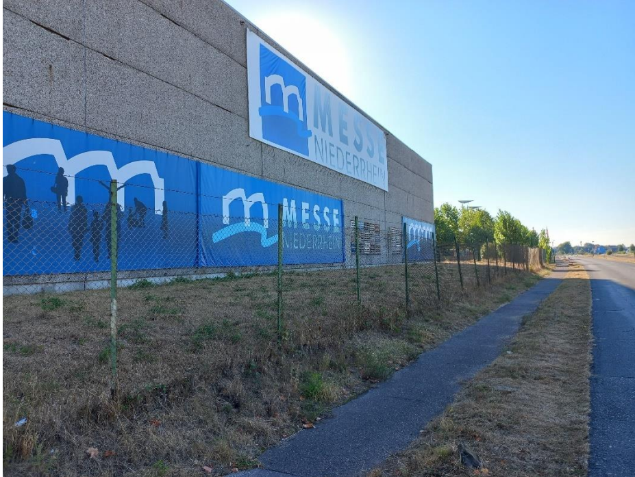
Blick auf eine der Messehallen im Südwesten
