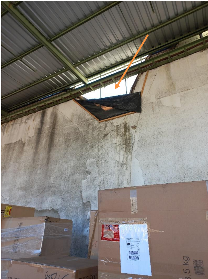
Offene Bereiche in den Lagerhallen bieten Einflugmöglichkeiten für Fledermäuse
