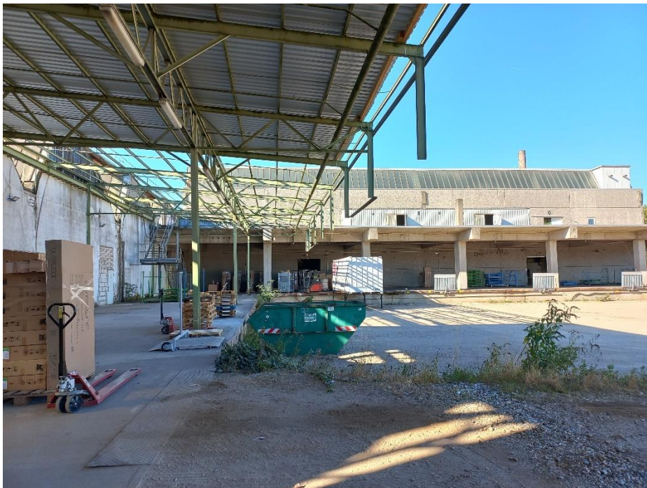
Blick auf den nördlichen Bereich des Gebäudekomplexes
