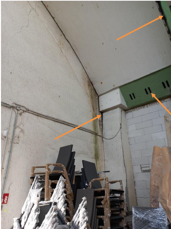
Mögliche Spaltenverstecke in den Lagerhallen
