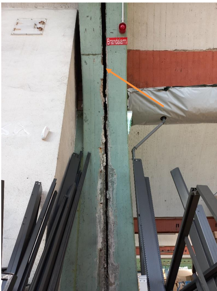
Mögliche Spaltenverstecke in den Lagerhallen
