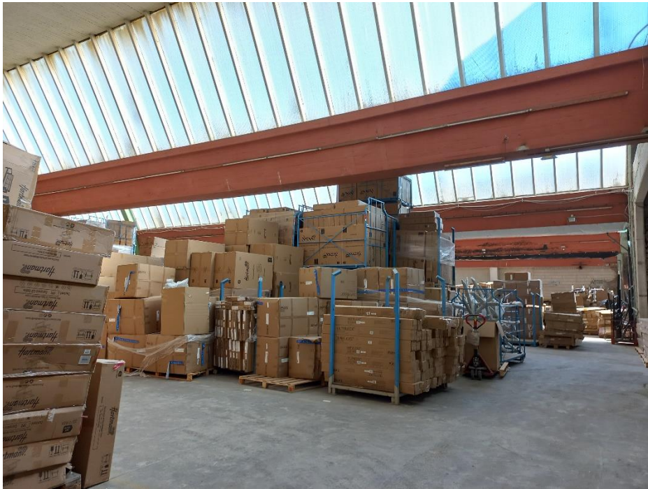
Eine der vielen Lagerhallen
