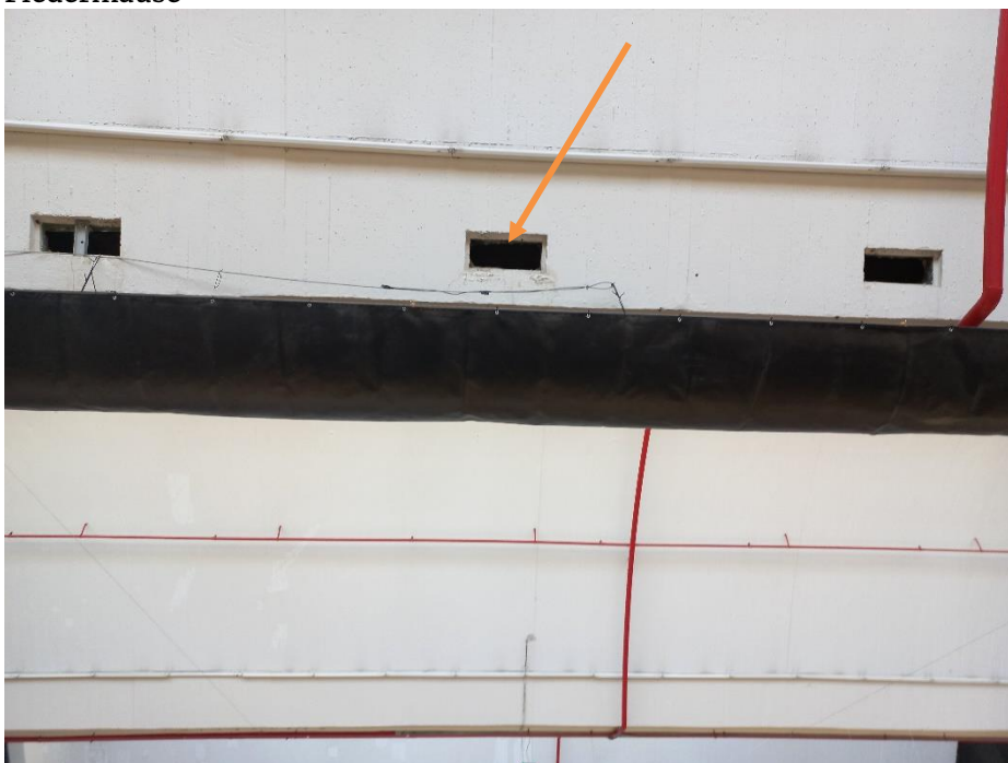
Weitere Einflugmöglichkeit in die Hallen von außen
