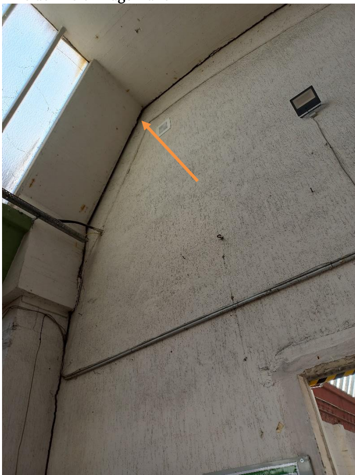
Mögliche Spaltenverstecke für Fledermäuse in einer der Lagerhallen
