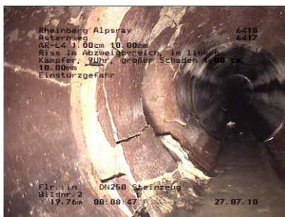
Scherbenbildung im Stützenbereich, großer Schaden
