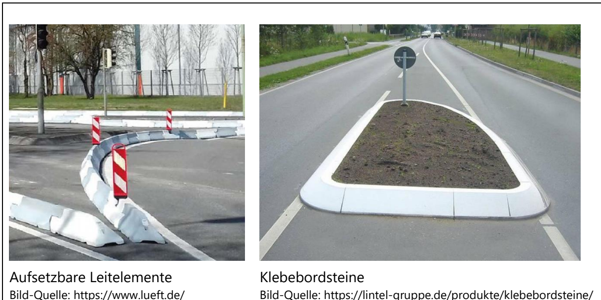
Abbildung 5: Mögliche Elemente für die baulichen Umgestaltung des Einmündungsbereichs (Beispiele)
